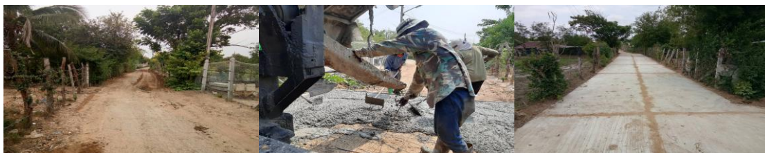
12. โครงการก่อสร้างถนน คสล. บ้านสระครก หมู่ที่ 10 จากบ้านนางเจือ ถึงประปาหมู่บ้าน (หนองคูขาด)
