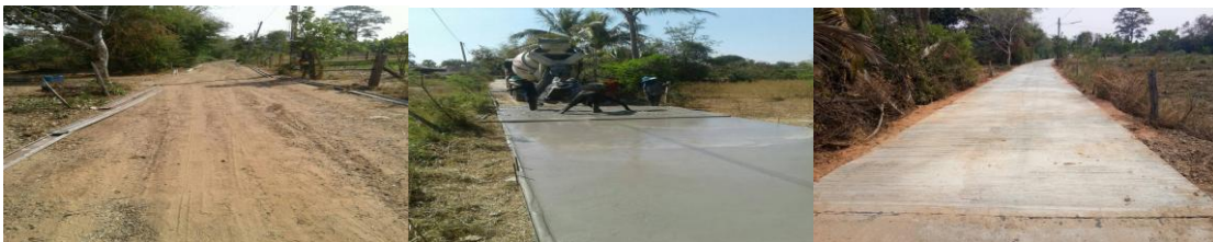
13. โครงการก่อสร้างถนน คสล. บ้านน้ำอ้อม หมู่ที่ 11 รอบสระน้ำอ้อม
