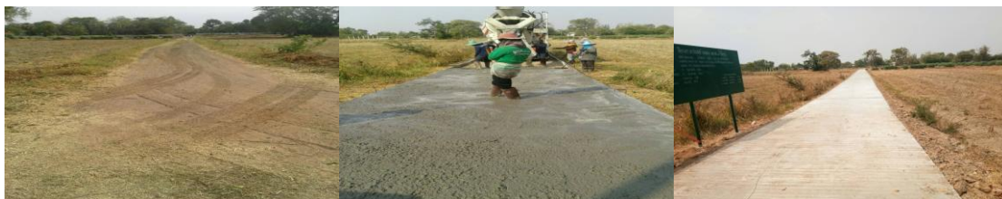
15. โครงการก่อสร้างถนน คสล. บ้านคิมม่วง หมู่ที่ 13 จากบ้านคิมม่วง เชื่อมต่อกุ่มสวนผัก
